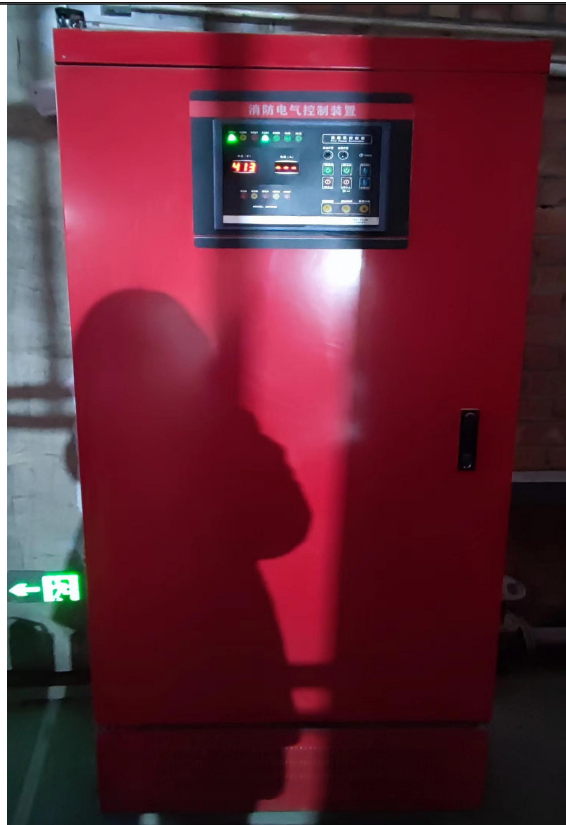
图3-7消防电气控制柜
